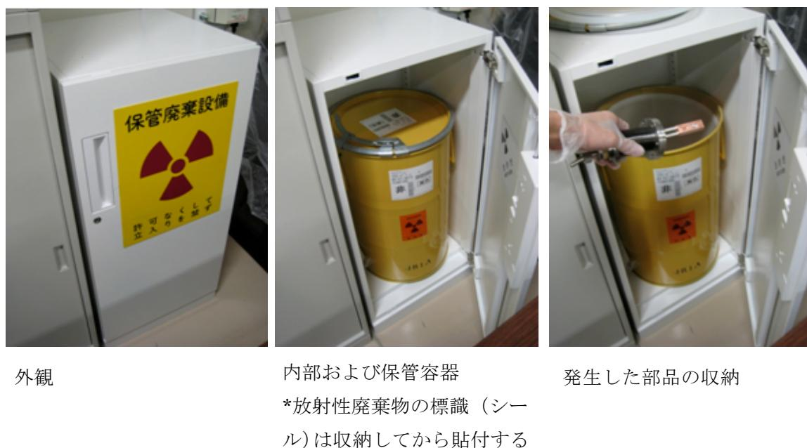
図 14.2 保管廃棄設備設置例 2
